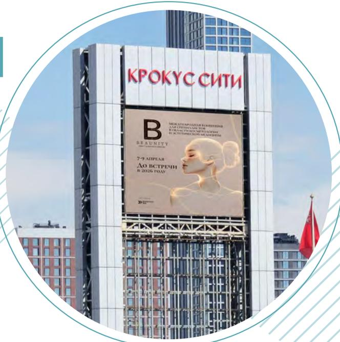
30-метровая стела с двумя установленными экранами на каждой из сторон (стороны «А» и «Б»).
