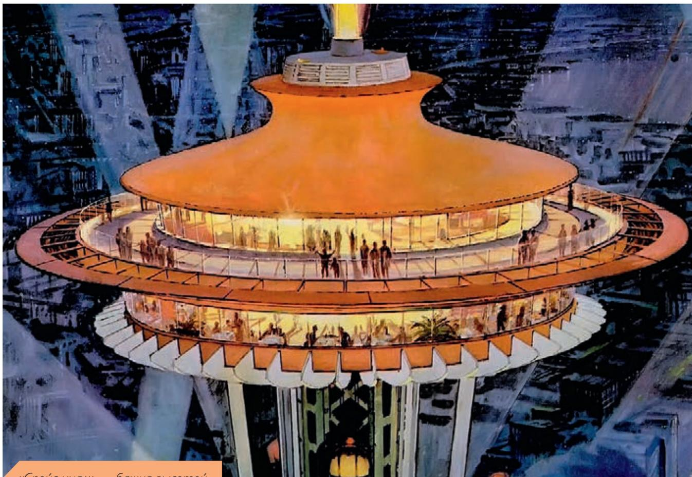
«Спейс-нигл» — башня высотой 184 м, шириной 42 м и весом 9,5 тыс. т. Она построена так, чтобы выдерживать ураганы со скоростью ветра до 320 км/ч и землетрясения до 9,1 балла. Это вдвое выше требований строительных норм на момент постройки. При ветре башня отклоняется примерно на 1 дюйм (2,5 см) на каждые 10 миль в час скорости ветра.
